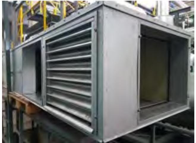
Figura 4. Collocamento in sicurezza della camera filtri della  $\mu$ GT.
