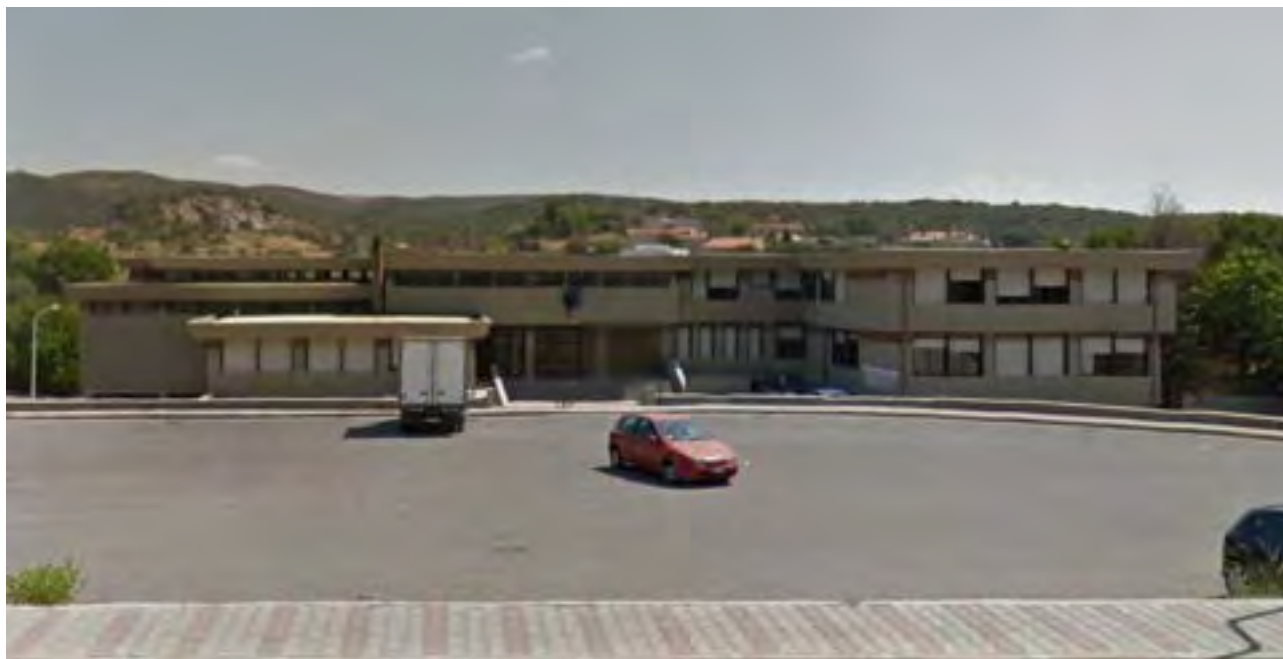
Figura 4.1. Vista dell'edificio ex Uffici Giudiziari
