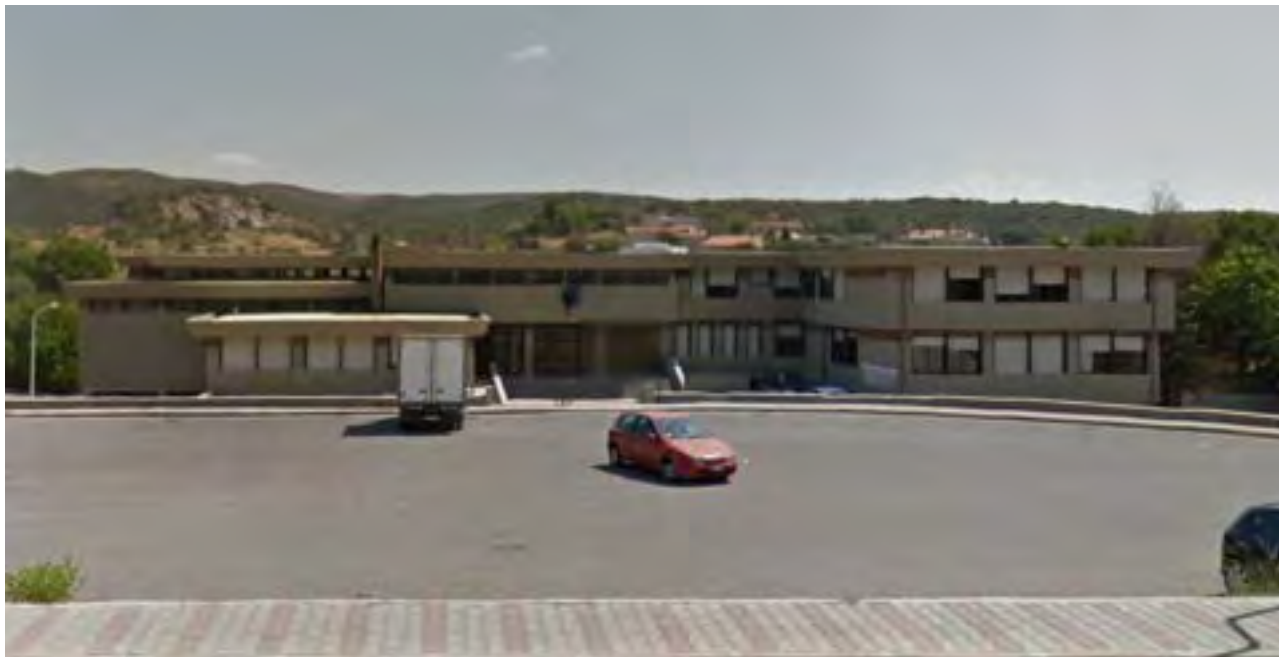
2.10 Vista dell'edificio dalla Via XVIII Dicembre
