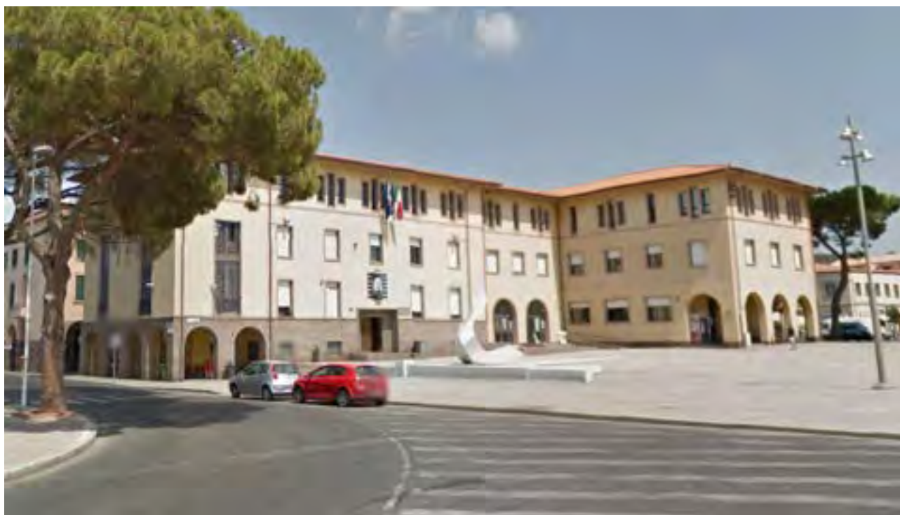
Figura 3.1. Vista dell'edificio Municipale di Carbonia
