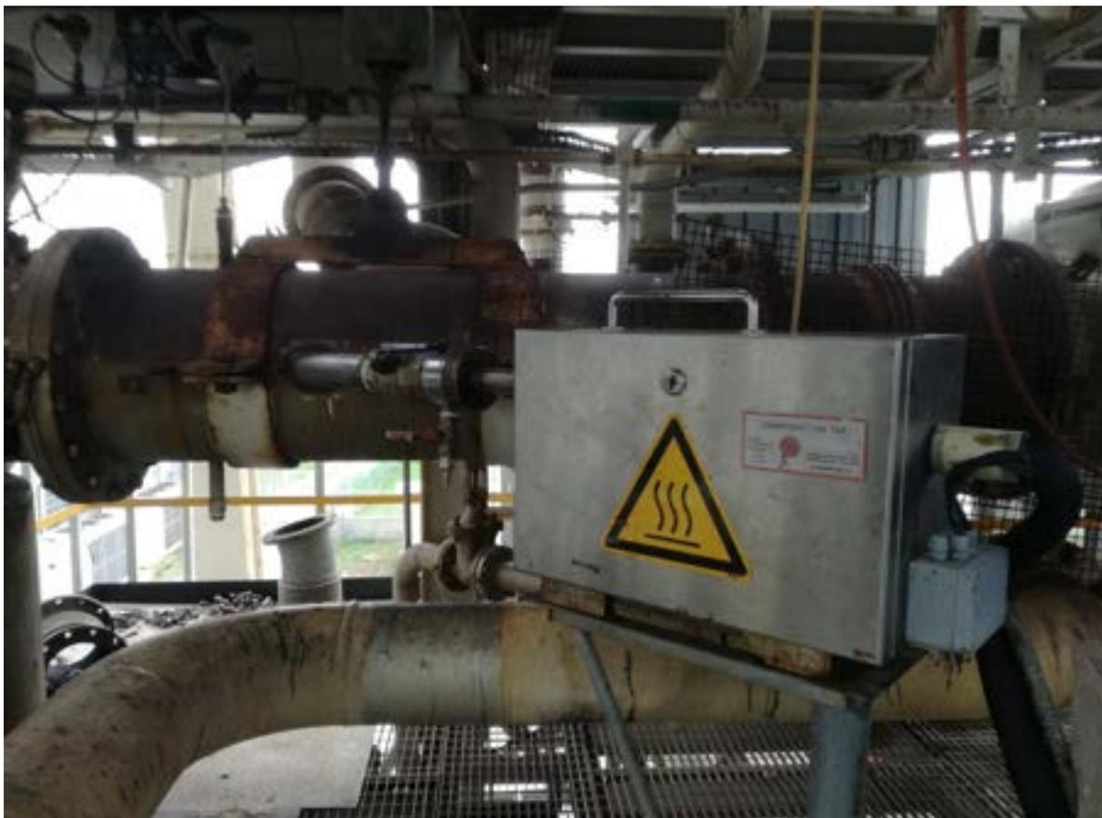
**Figura 9. Nuova installazione del sistema di campionamento TAR (Gamba&Botteghi)**
