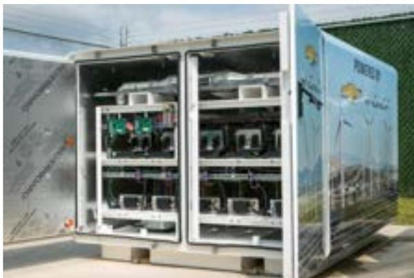
Figura 19. Sistema di accumulo realizzato con batterie Chevrolet
