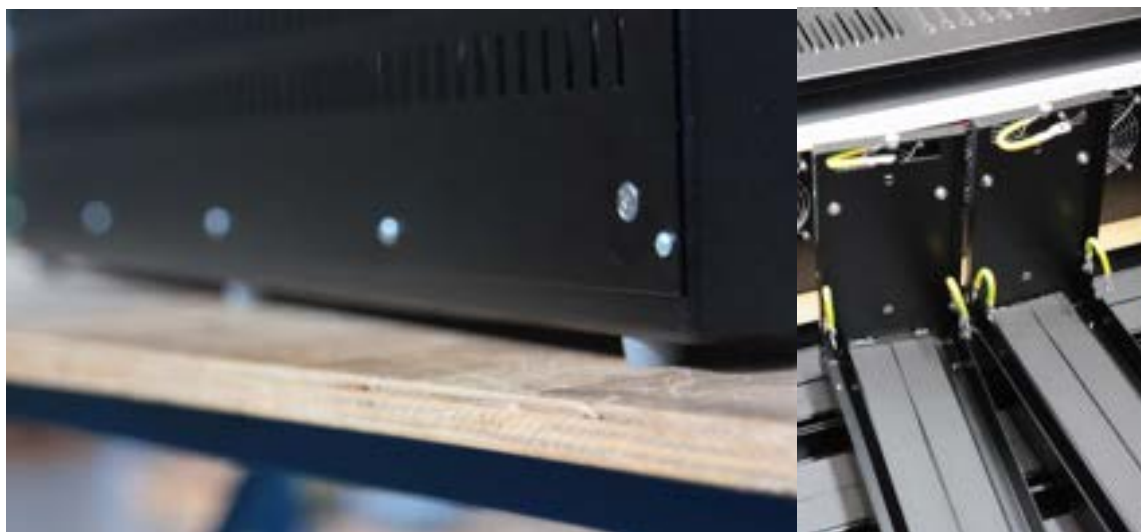
Figura 22. a) Sospensione dal terreno b) Isolamento elettrico e messa a terra
