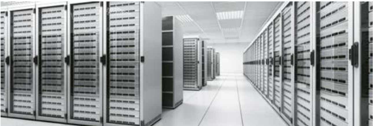
Figura 10. Sistema di storage SES Battery (sito SES)
