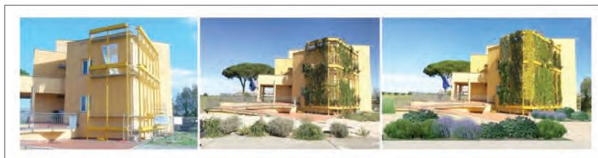
Fig. 1 Prototipo della parete-verde sull'edificio dimostrativo del Centro Ricerche ENEA Casaccia
