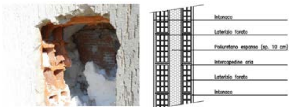
Figura 4.6. Tipologia muratura a cassetta
