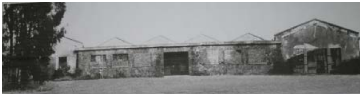
Figura 3.1. Facciata principale dell'ex Magazzino materiali prima dell'intervento di ripristino.
