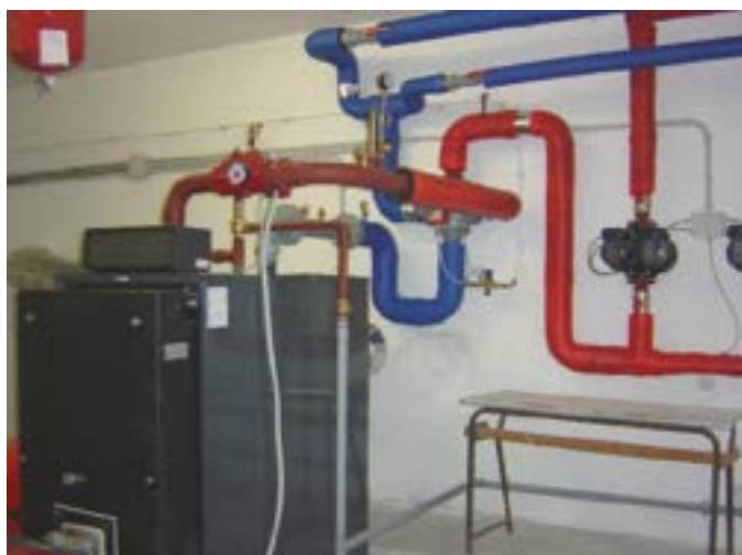
Figura 4.8. Generatore di calore.
