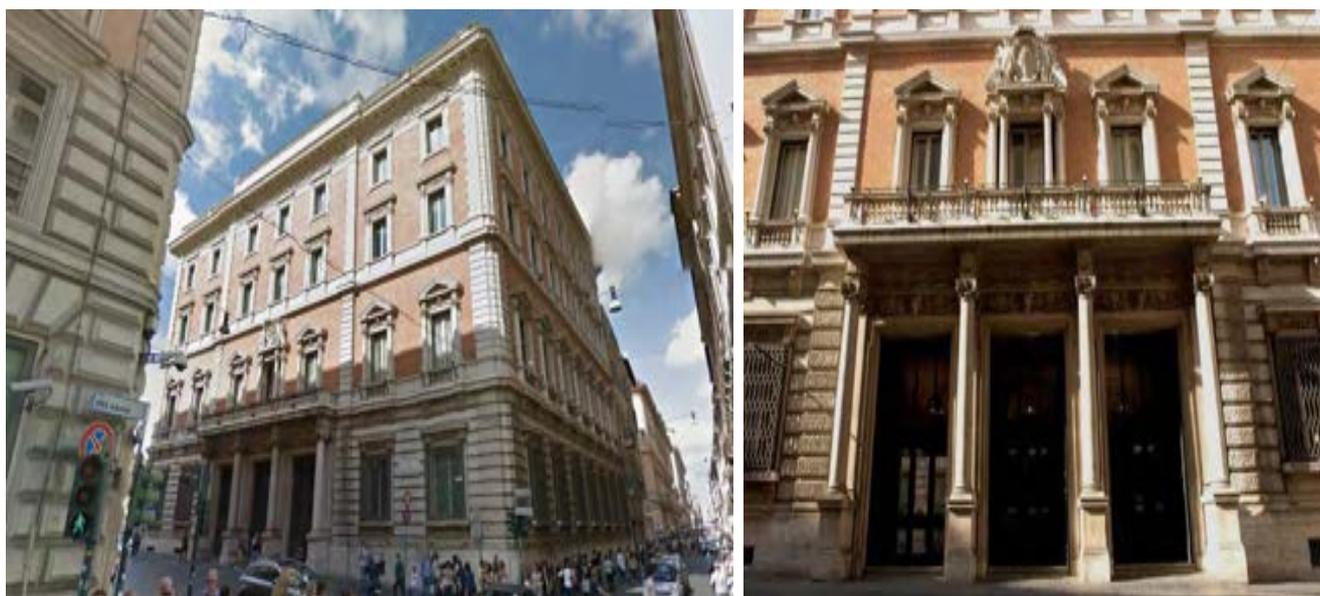
La struttura portante è costituita da muratura in pietra. Le chiusure opache verticali sono rivestite tutte da intonaco senza isolamento e le chiusure trasparenti, di geometria varia, sono tutte composte da telaio in legno con taglio termico con vetrocamera. Le coperture, in parte pavimentate e accessibili, non sono isolate termicamente. Il paramento esterno risulta invece costituito da pannelli prefabbricati in calcestruzzo, che sono in un ottimo stato di manutenzione
