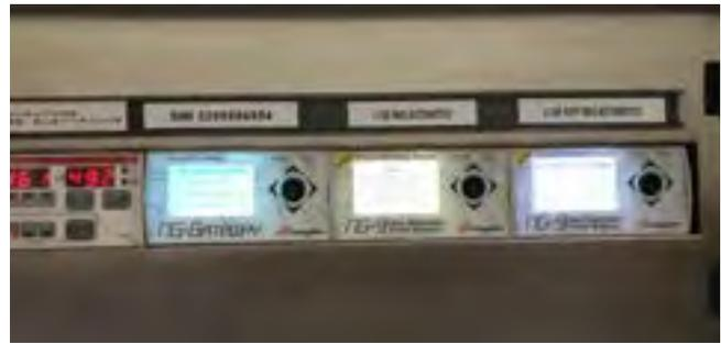
**Figura 10: Gateway e misuratori assorbimento elettrico chillers**
