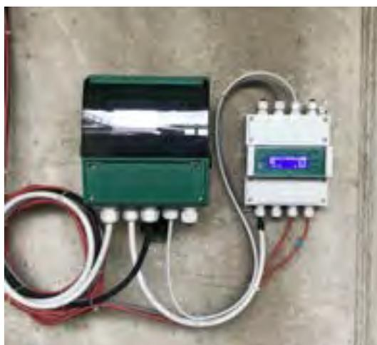
Figura 5 Assorbimento elettrico alla caldaia
