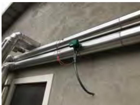
Figura 7: Misuratore energia termica – Linea Vapore al processo
