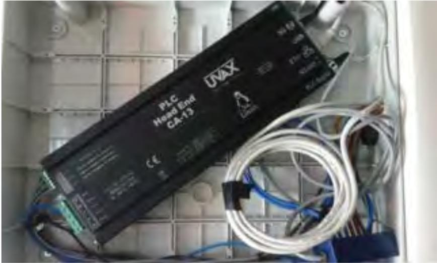
Figura 17 PLC installato in cabina per collegamento cabina-lampioni
