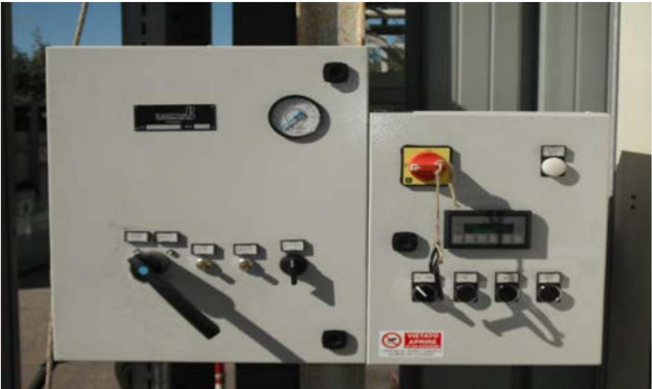
*Foto11. pannello di controllo del pistone*
