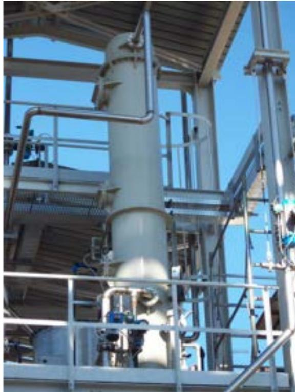
*Figura 2.4. Colonna a riempimento di desolforazione a freddo del syngas.*
