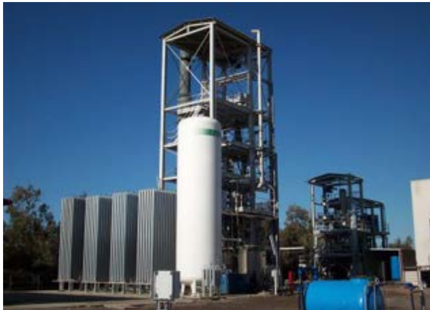
Figura 1.1. La piattaforma pilota Sotacarbo.
