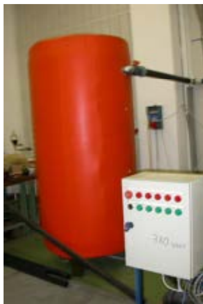
Fig. 19 – Serbatoio inerziale in fase di montaggio
