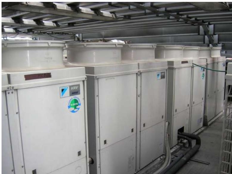
**Figura 2. Unità esterne condensanti / evaporanti installate nel sottotetto lato via Palazzo di Città**
