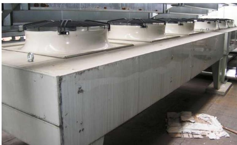
**Figura 4. Condensatore remoto del gruppo frigorigeno**
