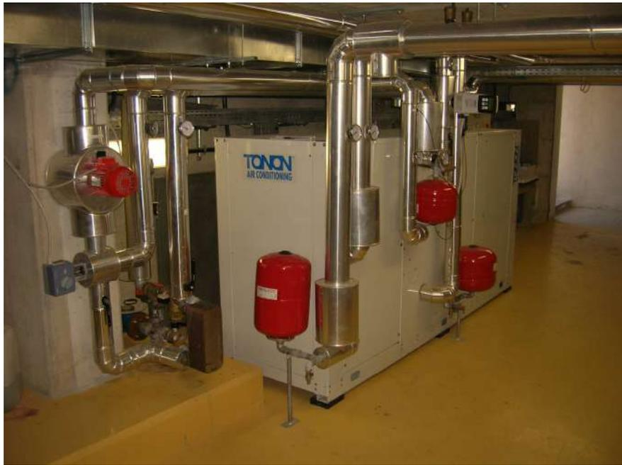
**Figura 3. Pompa di calore**
