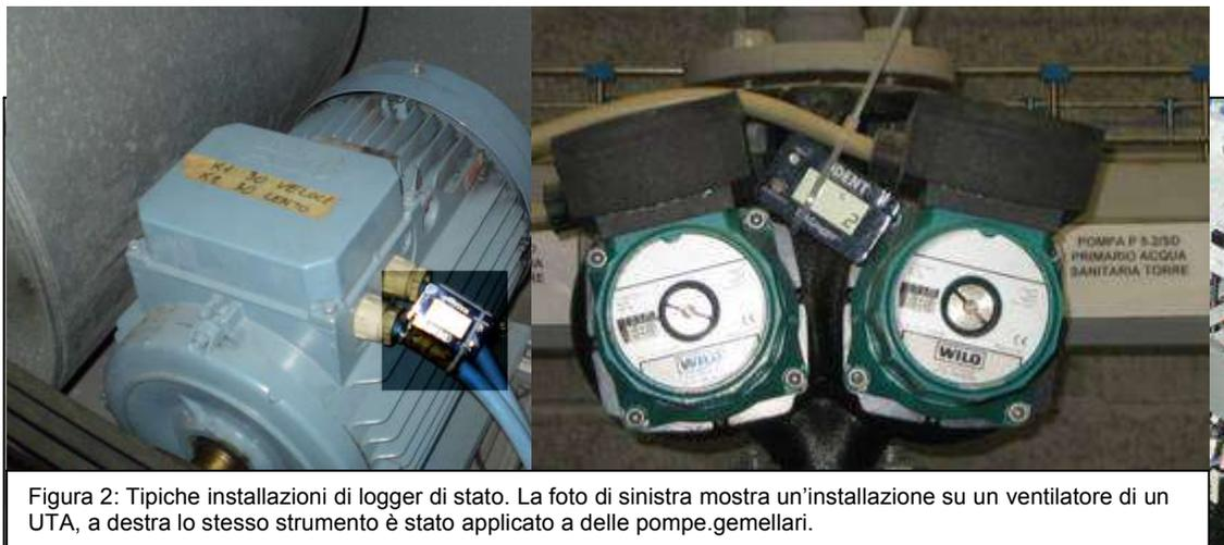
Figura 2: Tipiche installazioni di logger di stato. La foto di sinistra mostra un'installazione su un ventilatore di un UTA, a destra lo stesso strumento è stato applicato a delle pompe gemellari.
