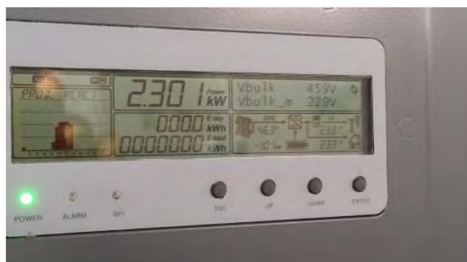
Figura 41. REACT1 con batteria in scarica P discharge = 1000W
