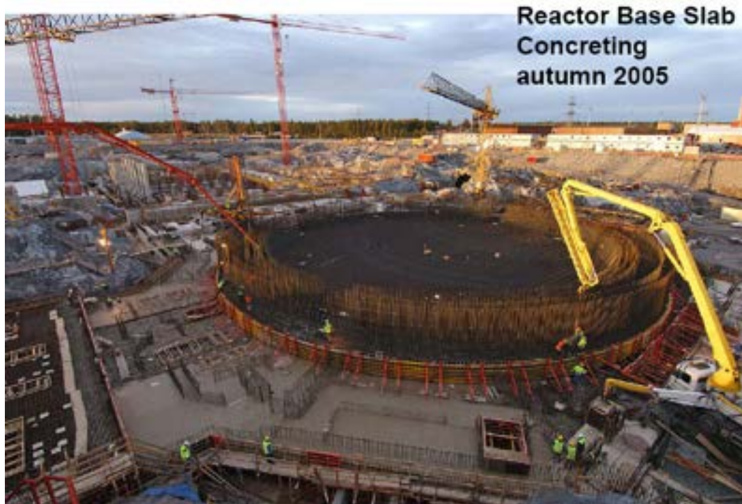
Figura 8 Base slab prima della messa in opera del calcestruzzo, autunno 05 (Martti K., 2006)
