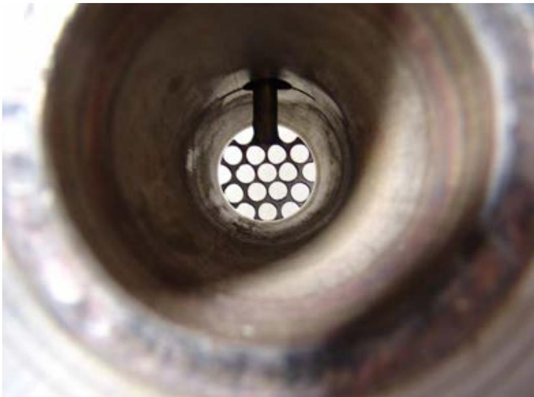
**Figura 8: Disco all'interno della tubazione da 3''**
