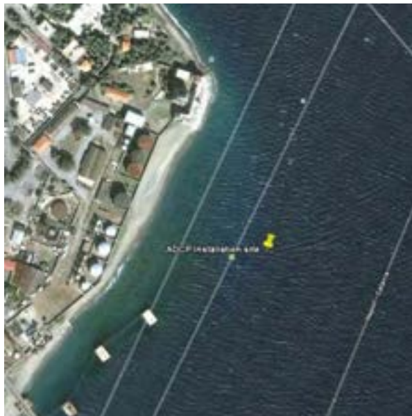
Figura 15. Sito di installazione del sistema di misura della corrente (ADCP), relativamente prossimo alla costa.
