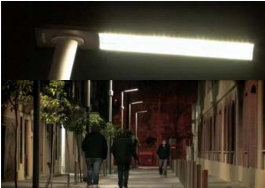
**Sistema tecnologico:** Il sistema prevede l'installazione di 12 pali di illuminazione stradale equipaggiati con la tecnologia LED, una cabina di servizio e controllo dell'intero apparato tecnologico che ingloba uno schermo che mostra le informazioni e due punti per la ricarica dei veicoli elettrici; infine un servizio di connessione Wi-Fi.
