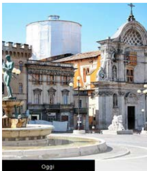
Figura 9a,b,c. Evoluzione dei lavori nel centro storico.
