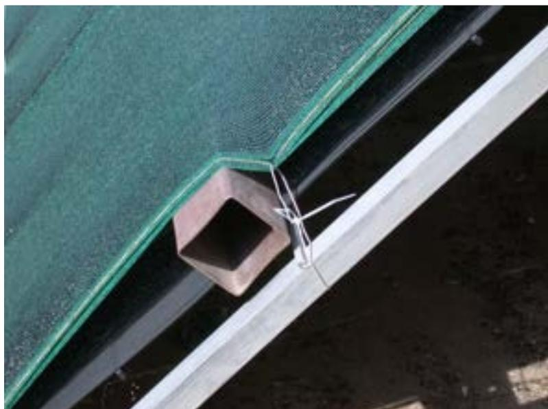
Figura 13; particolare che mostra i distanziatori inseriti per facilitare il passaggio dell'aria.
