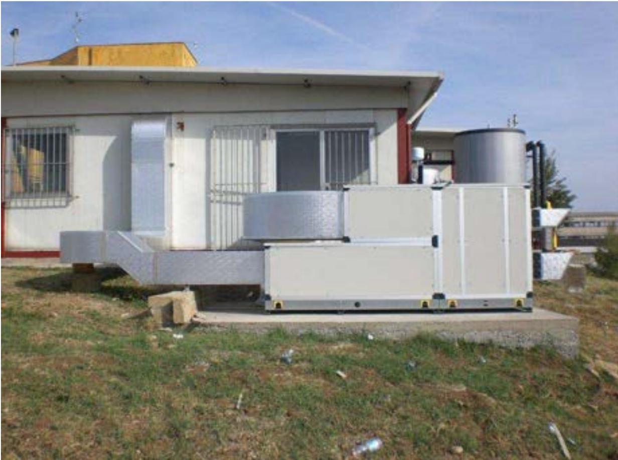
**Figura 17:** UTA LORAN: modalità di installazione
