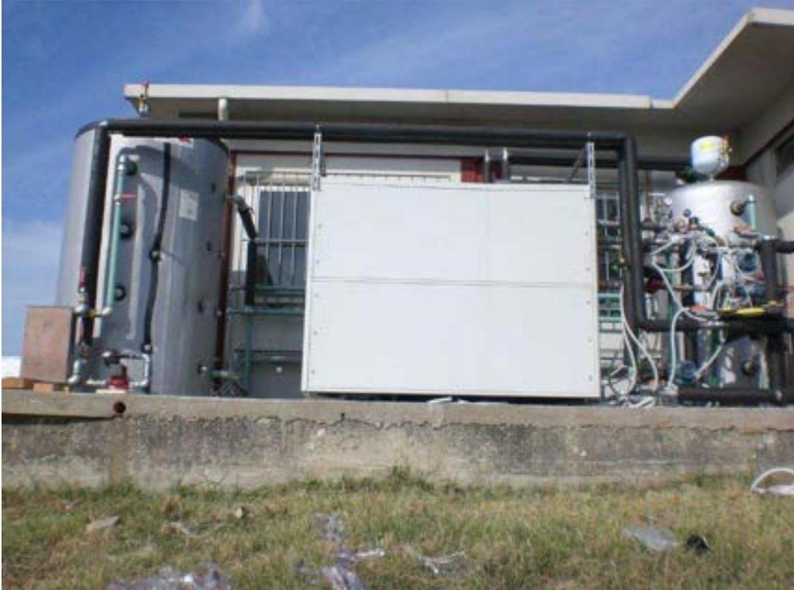
*Fig. 22 – Serbatoi inerziali: lato SX accumulo caldo, lato DX accumulo freddo*
