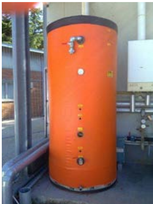
FIG. 13 – SERBATOIO DI ACCUMULO TERMICO IN FASE DI MONTAGGIO ( ZANI 1.5 M3)
