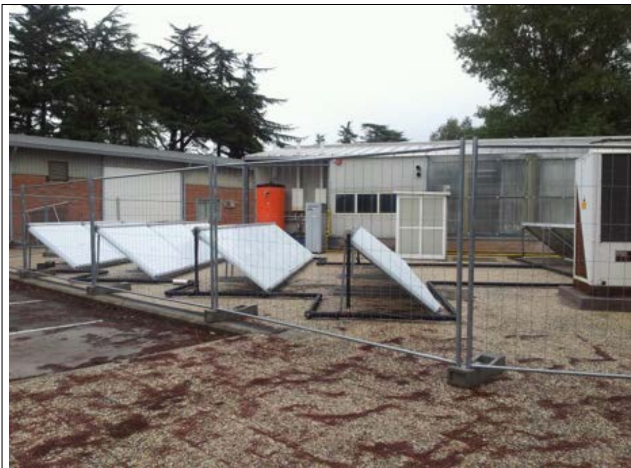
FIG. 7: CAMPO SOLARE IN FASE DI MONTAGGIO
