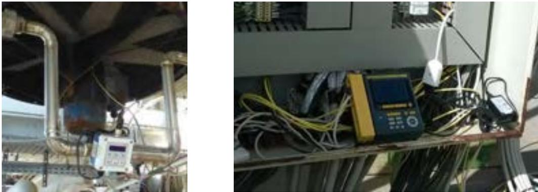
Figura 5.2. Misuratore di portata condensa ad ultrasuoni e datalogger di acquisizione
