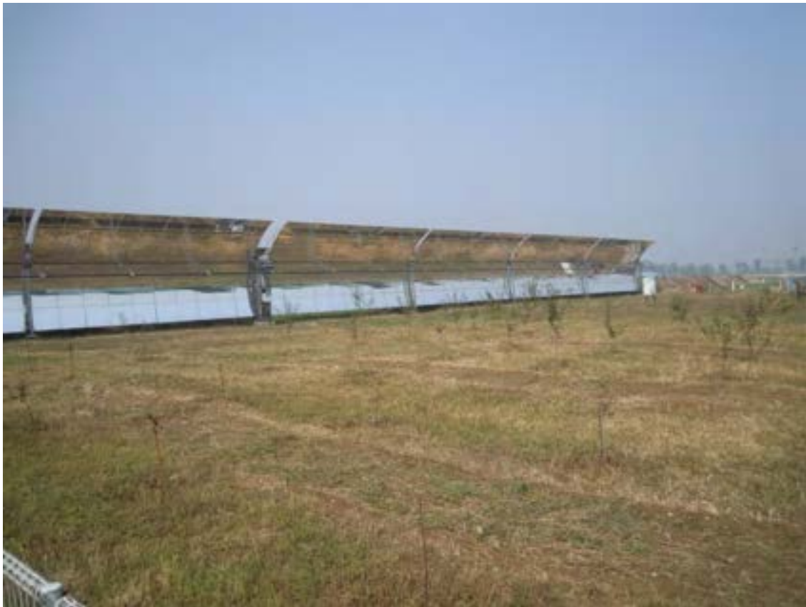
Fig. 5 – Collettore parabolico lineare sperimentale da 100 m.
