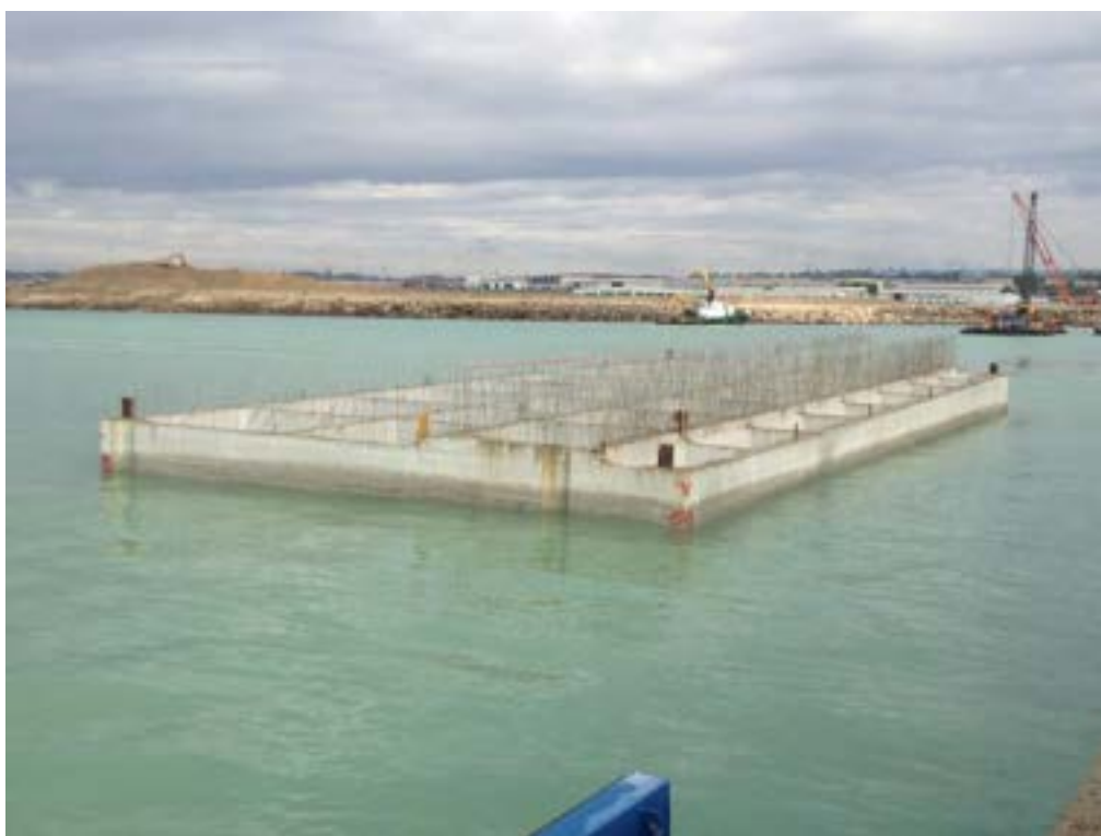
Fig. 38 - Costruzione del dispositivo REWEC3 nella nuova darsena di Civitavecchia
