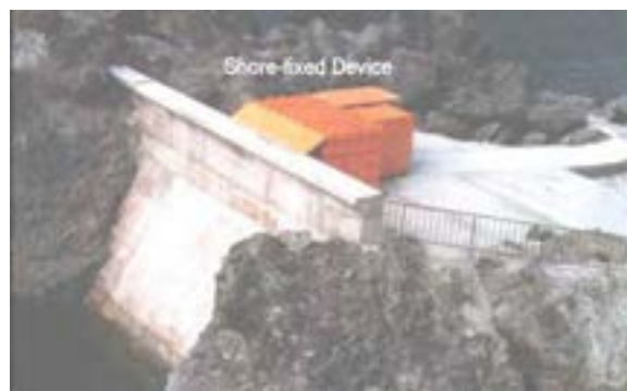
Fig 16 - Impianto OWC di Sanze
