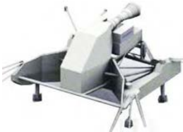
Fig. 19 – Modello dell’impianto OWC di Kembla
