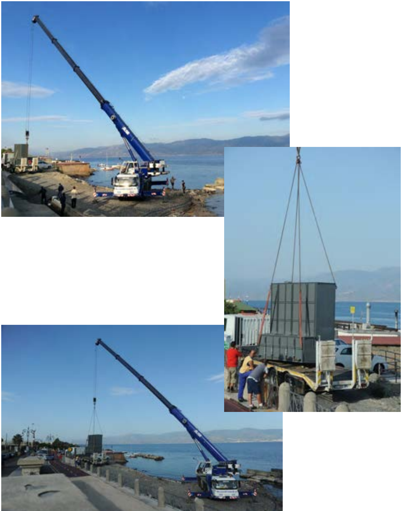
Figura 18. Fasi della posa del cassone in acqua 1/4
