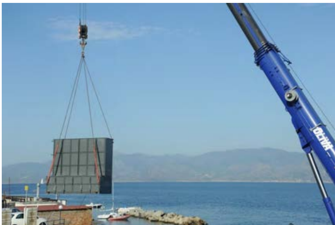
Figura 19. Fasi della posa del cassone in acqua 2/4
