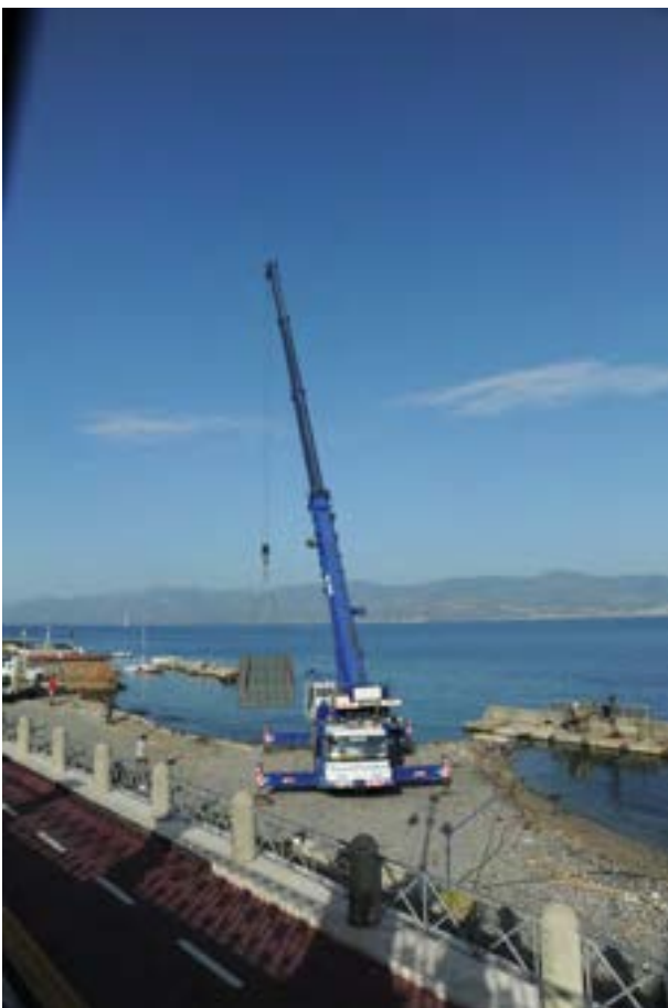
Figura 20. Fasi della posa del cassone in acqua 3/4
