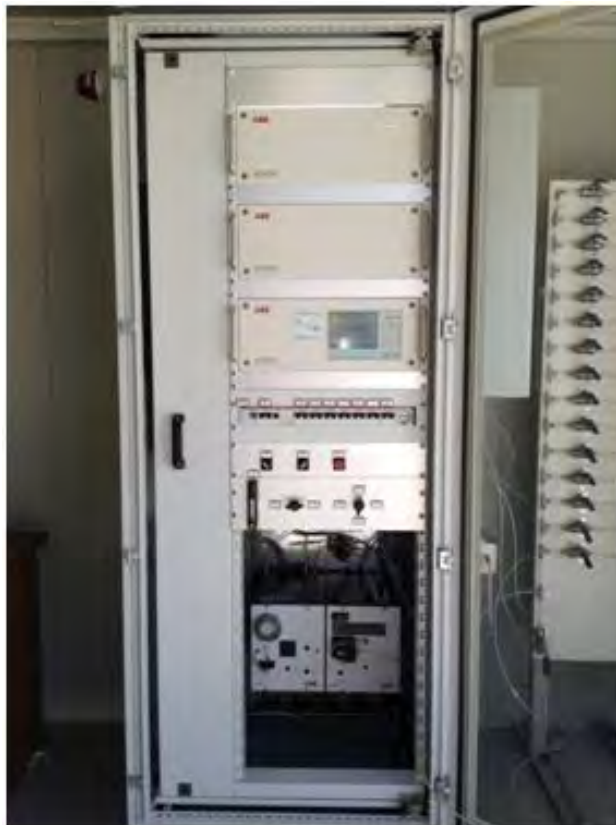
Figura 10. Sistema di campionamento e analisi gas ABB
