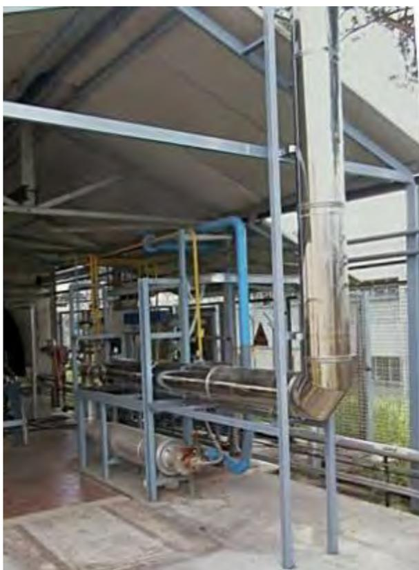
Figura 2-5: Vista del condotto di scarico dei fumi.
