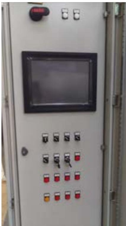
Figura 4-1 Quadro elettrico di controllo
