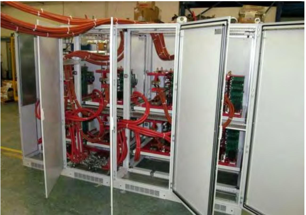
Figura 14. Armadio SCB, dal lato del circuito idraulico di raffreddamento ad acqua demineralizzata.
