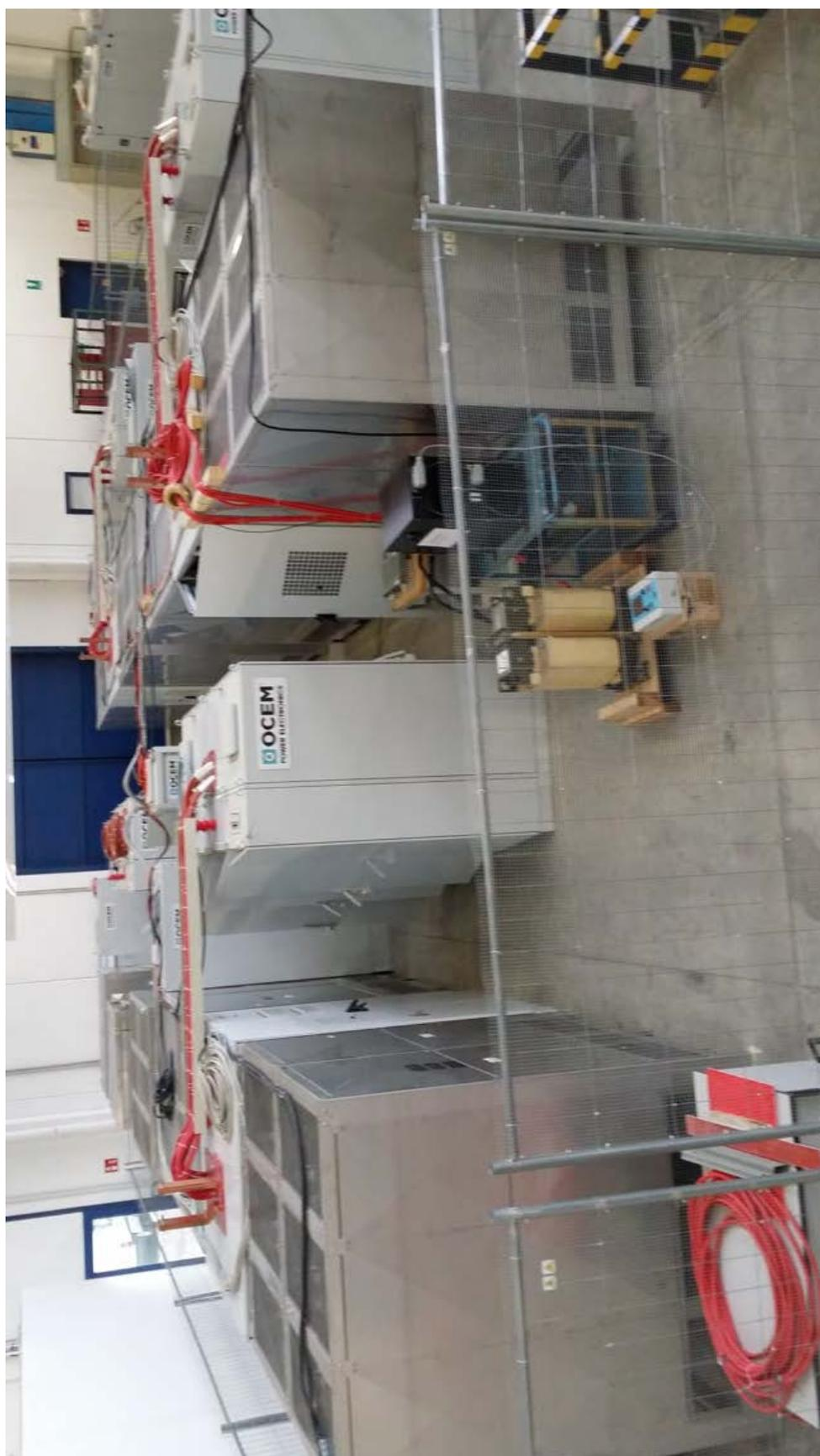
Figura 19. Sistema assemblato nella configurazione finale (con spazi più ristretti). Sono visibili le quattro SNU con l'LCC al centro (come in JT-60SA) e il generatore e il carico utilizzati per le prove di routine sulle SNU.
