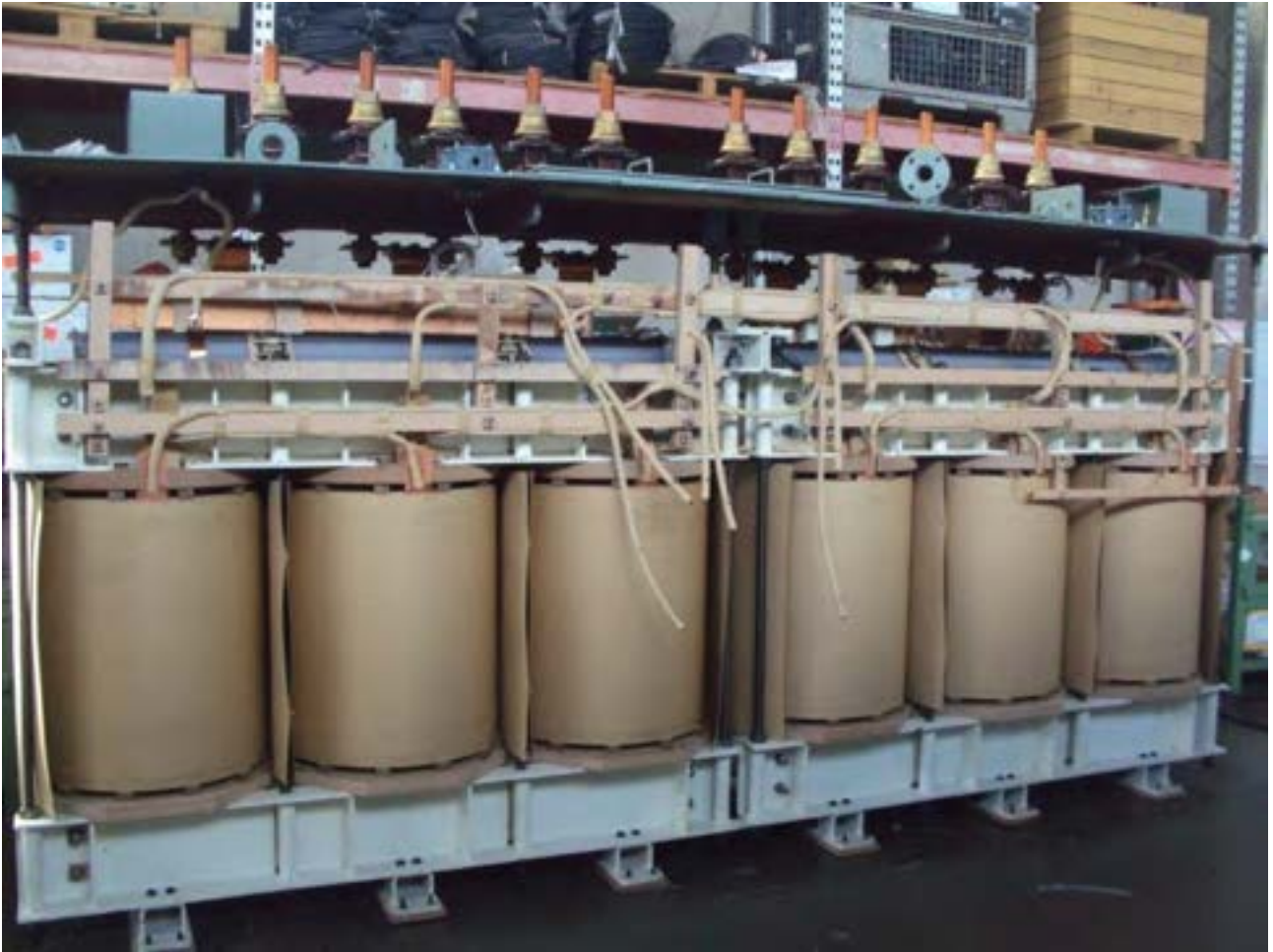
Figura 2 - Costruzione del trasformatore CS2.
