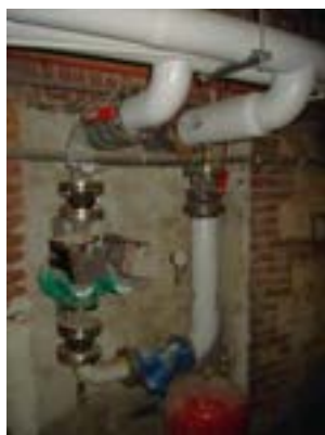
Figura 43 - Piè di stabile con allacciamento diretto
