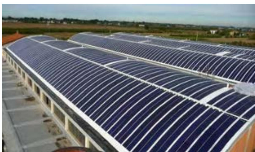
Figura 55 - Esempio di moduli fotovoltaici flessibili Solbian (sinistra) [47]. Realizzazione con moduli flessibili Derbisolar su edifici industriali (destra) [48]
