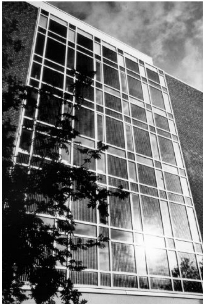
Figura 62 - La facciata continua della Utility company di Aachen, Germania del 1991. Una delle prime realizzazioni BIPV [56].
