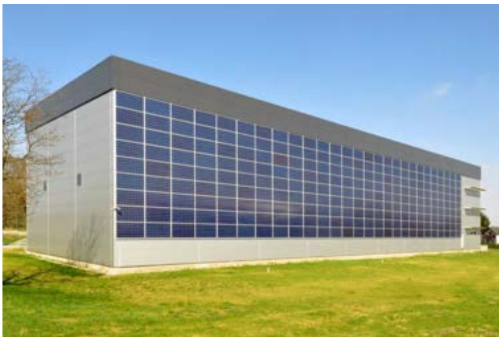
Figura 59 - Esempio di integrazione fotovoltaica in parete verticale (GMA Solar – Canada [51]).
