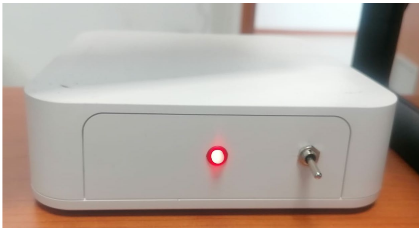
Figura 5 – il gateway installato.
