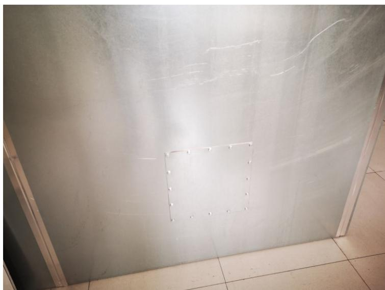
**Fig. 32. Apertura per ventilazione (chiusa da pannello d'acciaio) sul lato lungo della camera schermata.**
