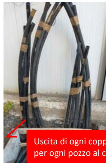
Figura 16. Sonde geotermiche e corrugato contenente la fibra ottica raccordati nei cavedi orizzontali fino al sito prescelto del collettore, adiacente la sala controllo
