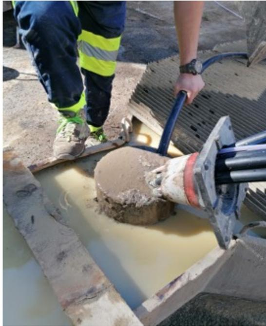
Figura 14. Cementazione del foro con malta cementizia
