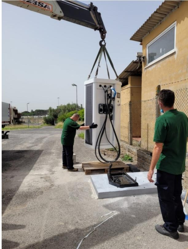
**Figura 14. Posizionamento della stazione di ricarica.**
