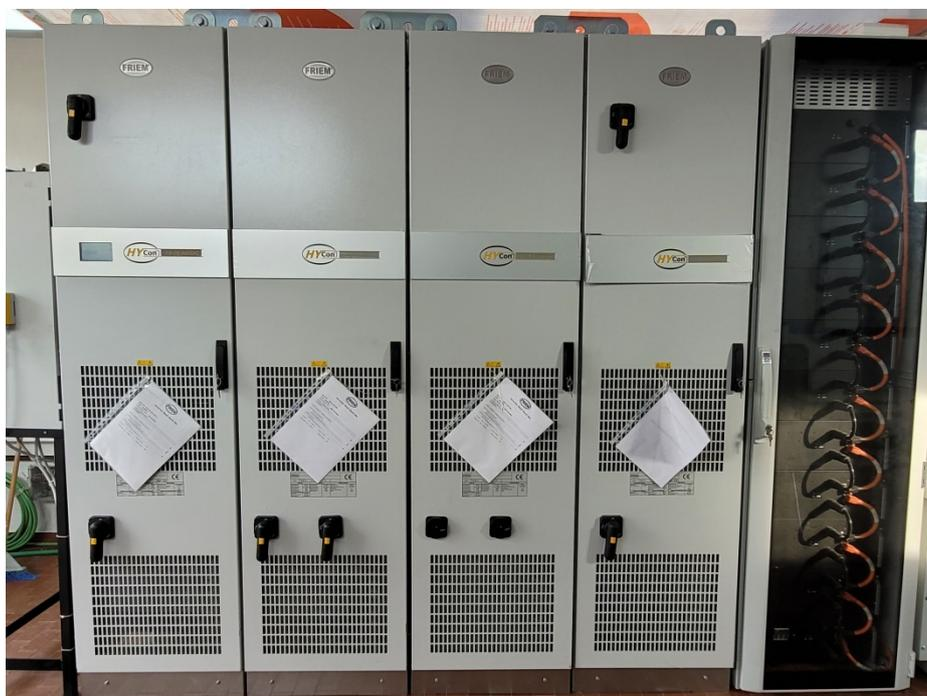
Figura 10. I convertitori FRIEM (a sx) e il sistema di accumulo FAAM (a dx).
