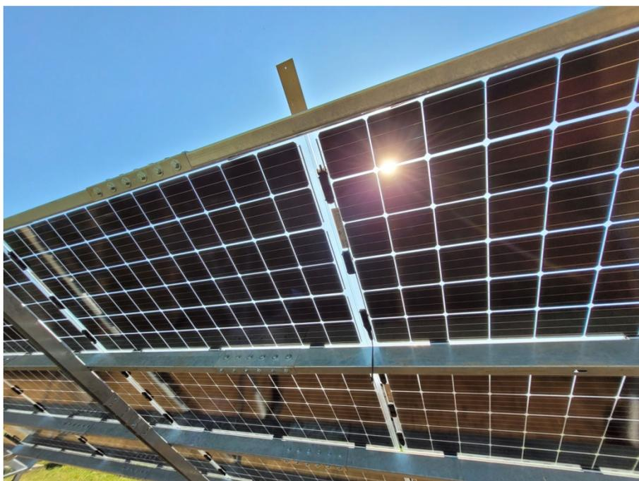
Figura 8. Particolare di montaggio dei moduli fotovoltaici bifacciali EGP 3SHB370D.
