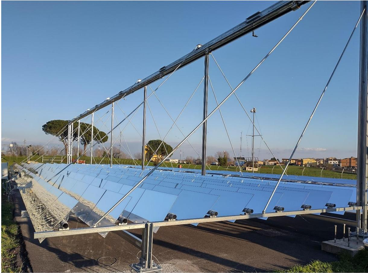
**Figura 2. Collettore lineare Fresnel installato presso il CR ENEA Casaccia.**
