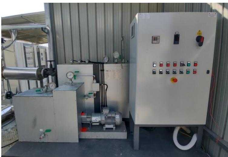
Figura 4. Riscaldatore elettrico per olio diatermico.
