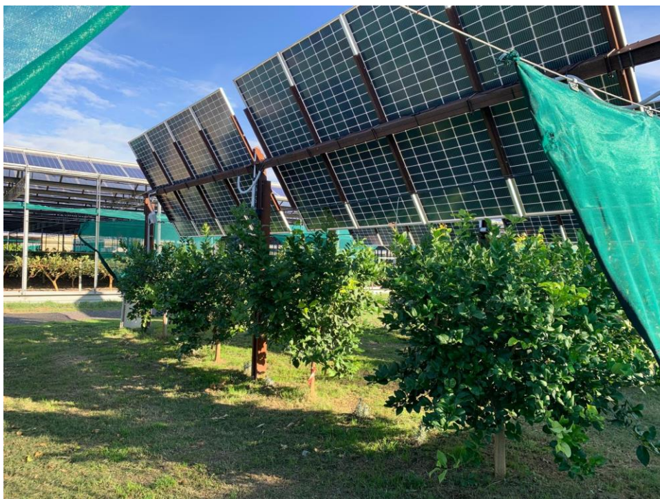
Figura 2 - Impianto agrivoltaico ad inseguimento: dettaglio dei nuovi moduli fotovoltaici
