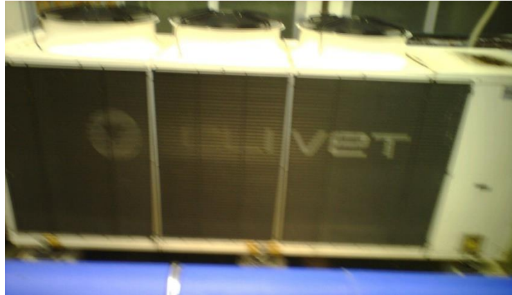
Figura 13 - Superficie oggetto di misure intensimetriche per la PdC aria-acqua
