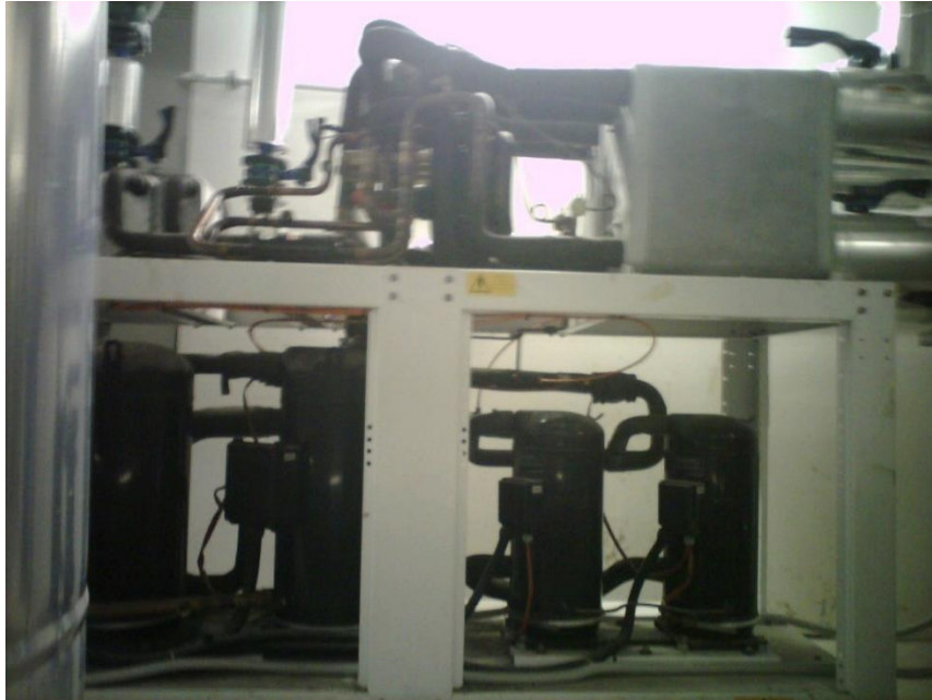
Figura 3 - Superficie oggetto di misure intensimetriche. In basso a destra la zona con i compressori
