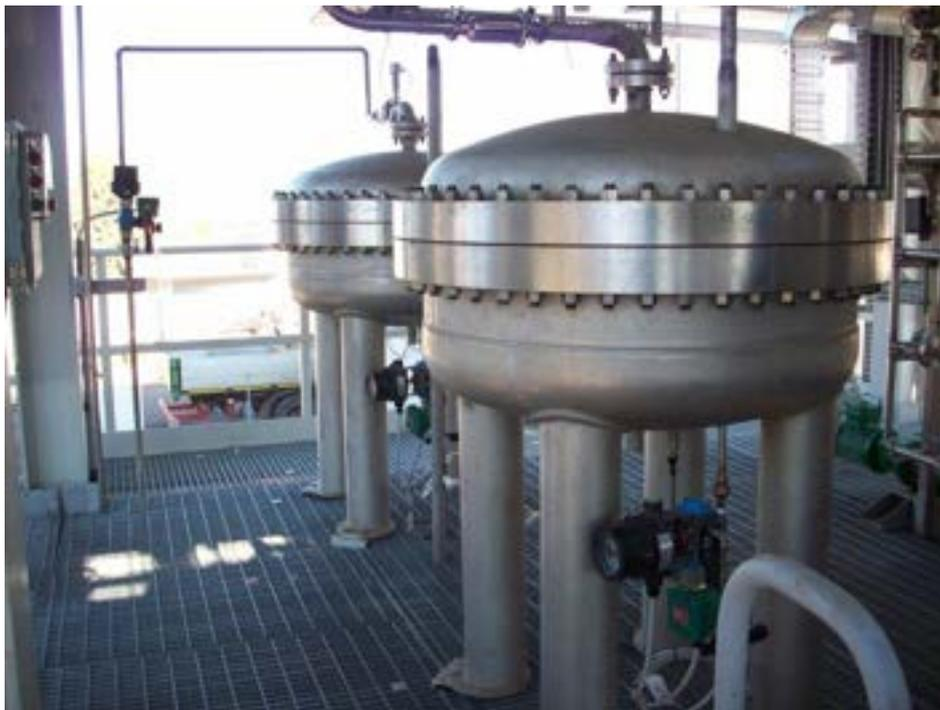
**Figura 7. Reattori di assorbimento dell'anidride carbonica RO001 e RO002**
