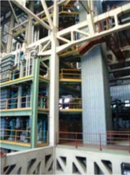
Fig. 24 - Attuale posizione dell'ascensore nel futuro vano SPES-3
