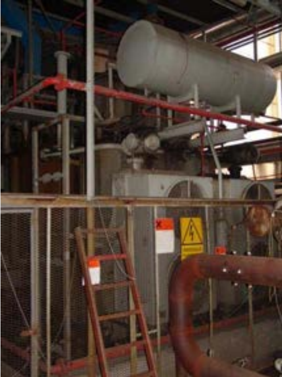
Fig.22 -Trasformatore 8MW
