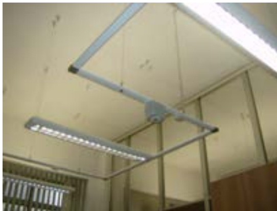
Figura 3.13 - Collocazione in ambiente di un sensore misto
