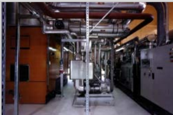
Figura 20 - Impianto CHP a biomassa di Bière che alimenta il sistema di teleriscaldamento di Place d'Armes de Bière, con utilizzo stagionale da novembre a maggio (temperatura acqua di raffreddamento 60/80°C). L'impianto ha vinto il Prix Solaire Suisse nel 1999. Fonte: www.turboden.it .
