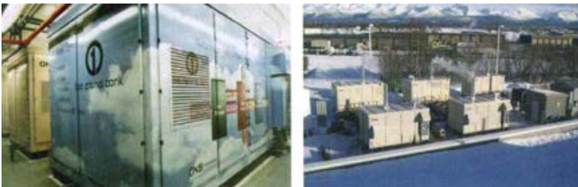
Figura 55 – Immagini di moduli UTC “PureCell 200” o “PC25” da 200 kW el installati in USA (Alaska, a destra) e Giappone (a sinistra). Fonte: E. Macchi, S. Campanari, P. Silva, La microgenerazione a gas naturale , 2005, Polipress, Milano.
