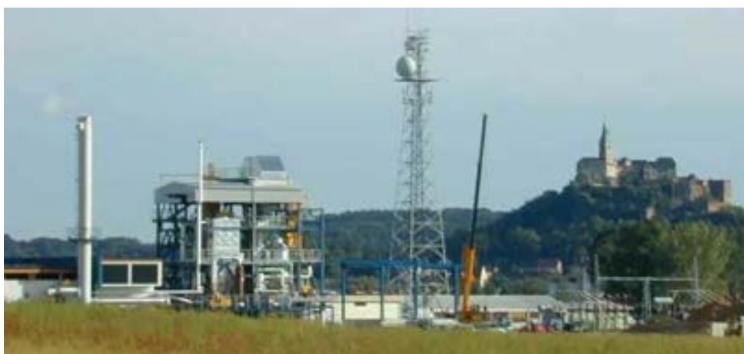
Figura 58 - Impianto di Gussing in Austria.
