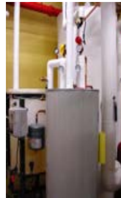
Figura 16 - Struttura e aspetto esterno di un serbatoio di accumulo per impianti solari termici.
