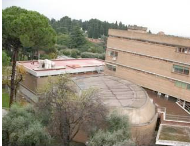
Figura 57. Vista del blocco B dell'edificio
