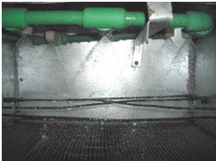
Figura 11: Sistema ad ugelli utilizzato per l'umidificazione del flusso d'aria secondaria
