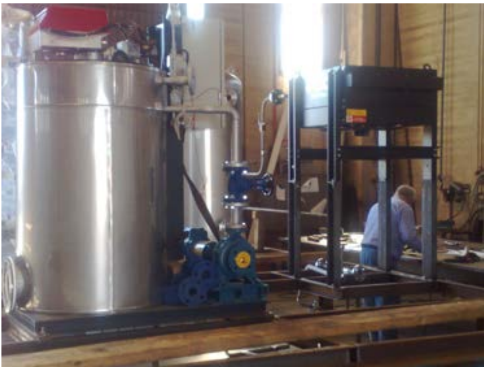
Fig. 16 – Foto durante le fasi di lavorazione
