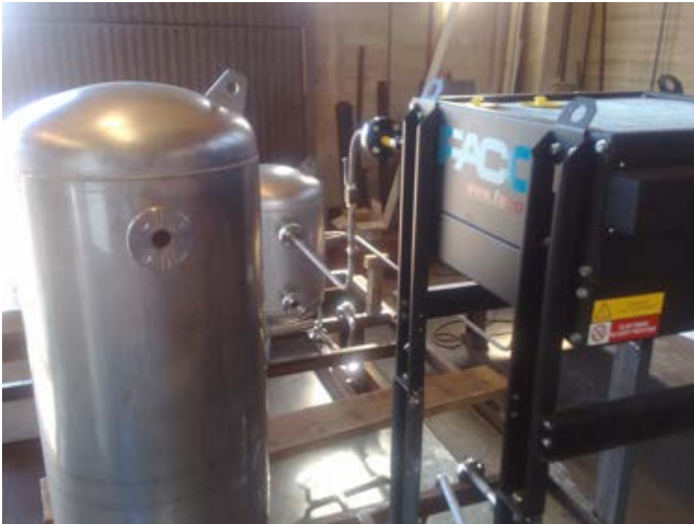
Fig. 15 – Foto durante le fasi di lavorazione
